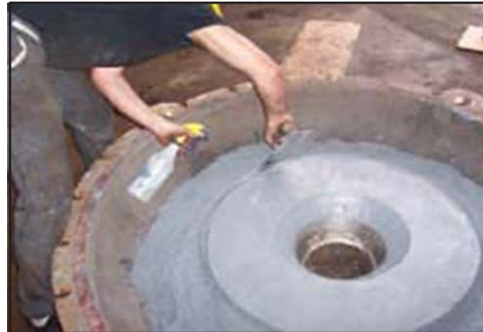
Aplicación de productos ARC.
